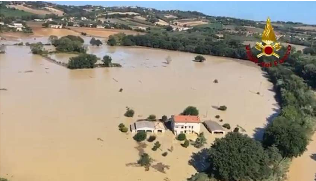
Alluvione Marche, settembre 2022
